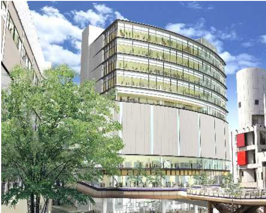
柏高島屋ステーションモール 新館全景
